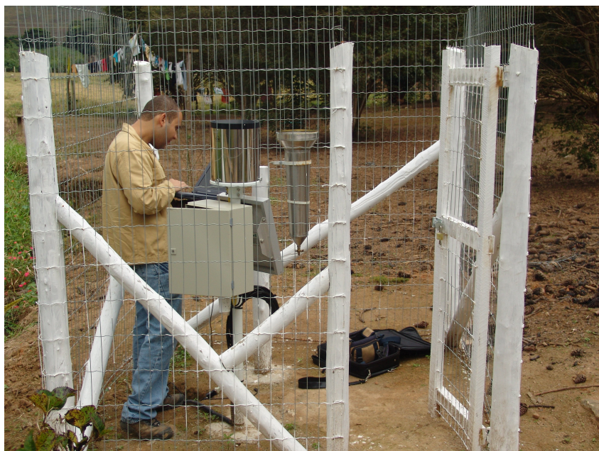
Figura 5.4 – Estação pluvio-fluviométrica instalada no baixo curso na bacia.
